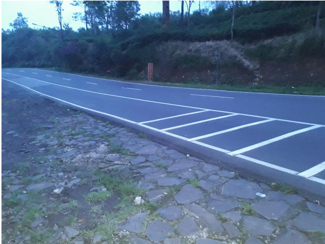
Gambar 17. Marka jalan dan pita penggaduh di jalur pendekat lokasi rawan kecelakaan. Jumlah lajur ada 3 lajur (2 lajur tanjakan dan 1 turunan)
