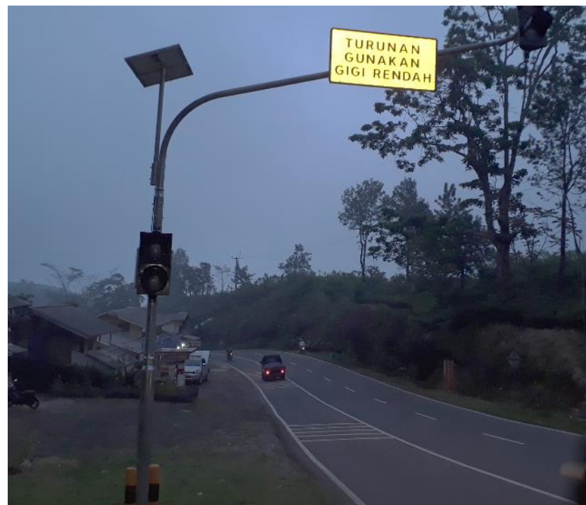
Gambar 18. Warning Light dan rambu peringatan di jalur pendekat lokasi rawan kecelakaan
