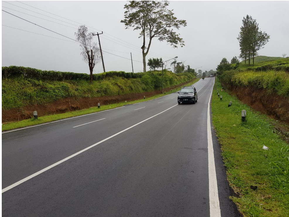
Gambar 19. Lingkungan sepanjang Jalan Raya Subang Ciater Kabupaten Subang.
