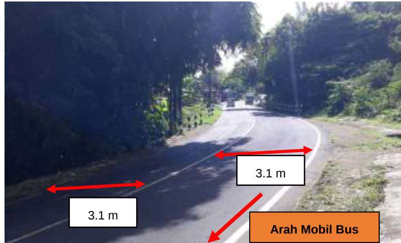
Gambar 24. Kondisi Jalan Dari Arah Datangnya Mobil Bus
