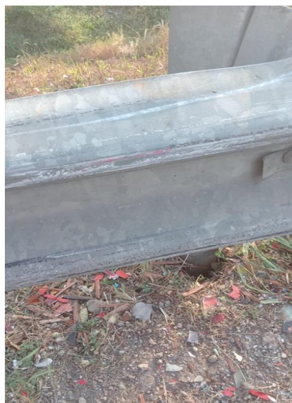
Gambar 23. Scratch mark berwarna merah di guardrail
