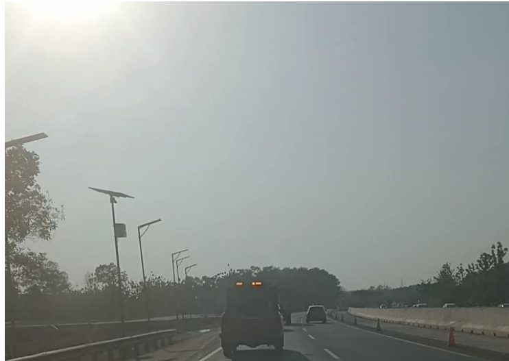
Gambar 25. Kondisi Prasarana Jalan Lokasi Kejadian Kecelakaan
