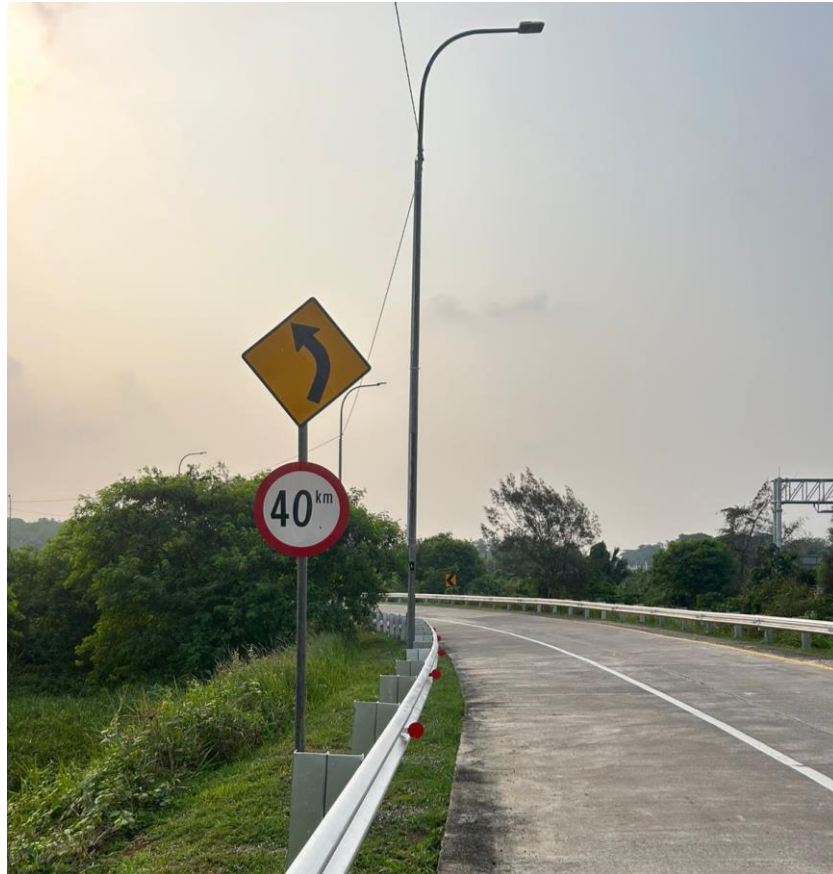
Gambar 15. Terdapat rambu peringatan jalan sedikit belok dan rambu batas kecepatan 40 km/jam di tikungan
