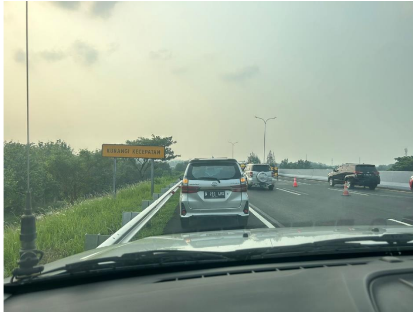
Gambar 13. Terdapat rambu peringatan dengan kata-kata “KURANGI KECEPATAN” di \pm 150 m dari ramp off
