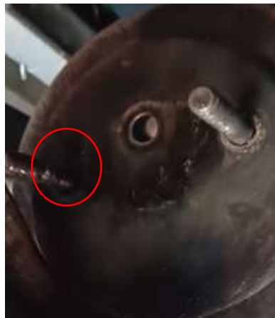
Gambar 16. Kondisi relay valve dan air brake chamber
