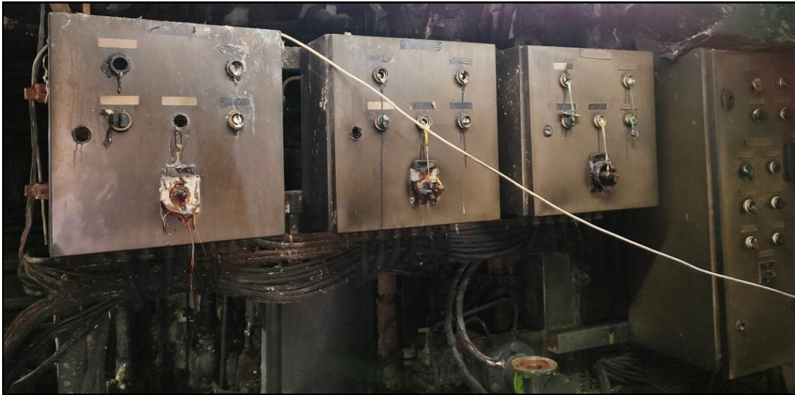
Gambar I-6: Tombol dan kenob panel kontrol permesinan yang meleleh karena panas
