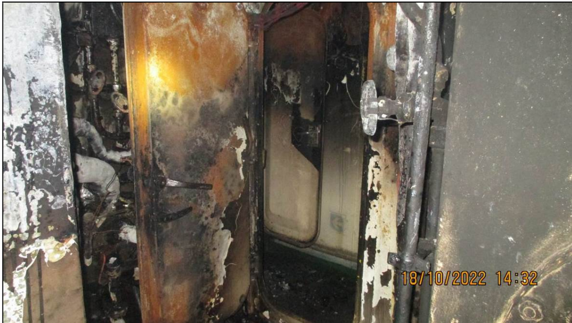
Gambar I-12: Kondisi pintu sebagai akses ke ruang MDB
