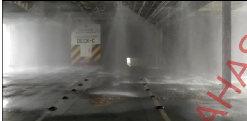
Gambar I-5. Pengujian Kerja Sprinkler Pada Bulan Oktober 2022
