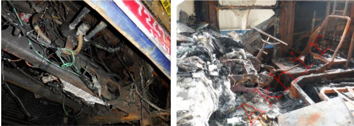
Gambar 3: Kondisi kabel listrik di bagian bawah ruang kemudi bus A (kiri) dan area tempat duduk pengemudi Bus A (kanan)
