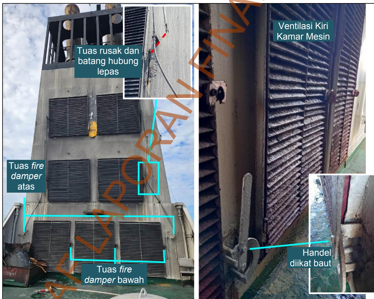
Gambar 9 Bukaan Kamar Mesin di Cerobong dan Dek 8 Kanan Kiri
