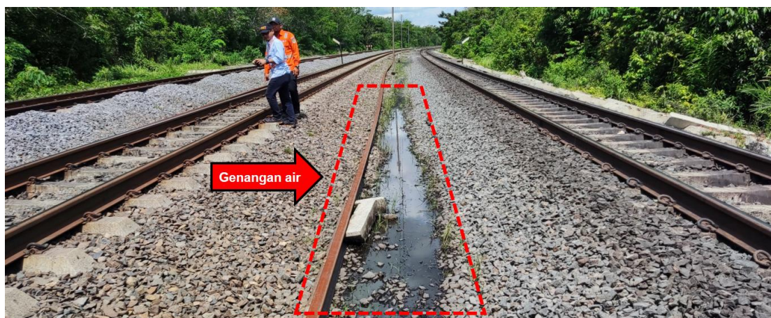
Gambar 18. Genangan air di sekitar jalur hulu (09-11-2022)
