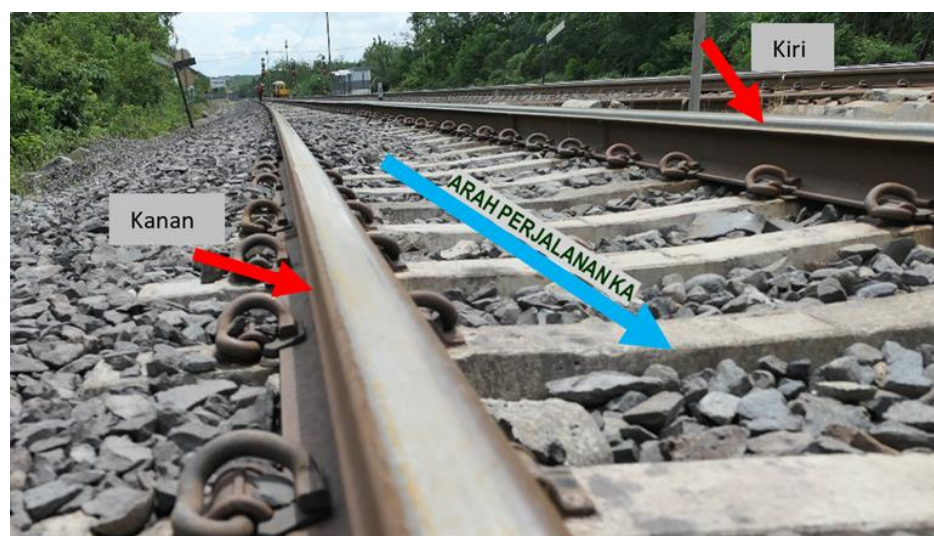
Gambar 14. Rel kiri aus dan rel kanan sudah dibalik penggunaannya
