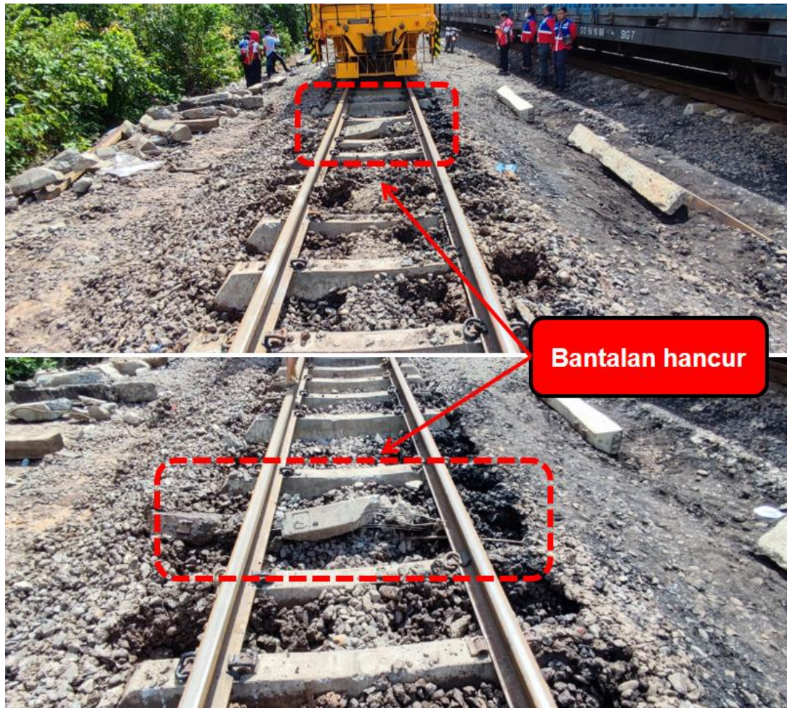
Gambar 26. Bantalan hancur setelah dilakukan pemecakan
