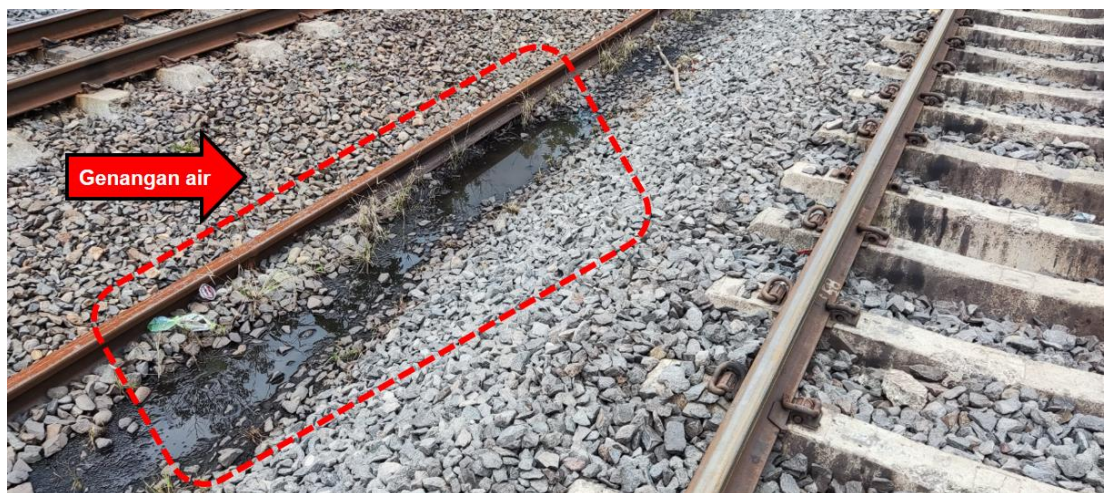
Gambar 16. Genangan air di sekitar jalur hulu (05-10-2022)
