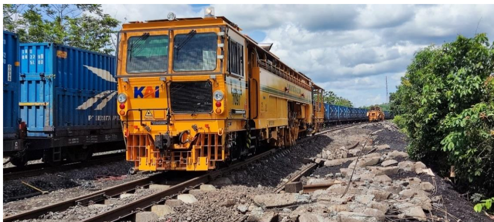
Gambar 23. MTT yang sudah siap memecok balas di jalur hulu (06-10-2022)
