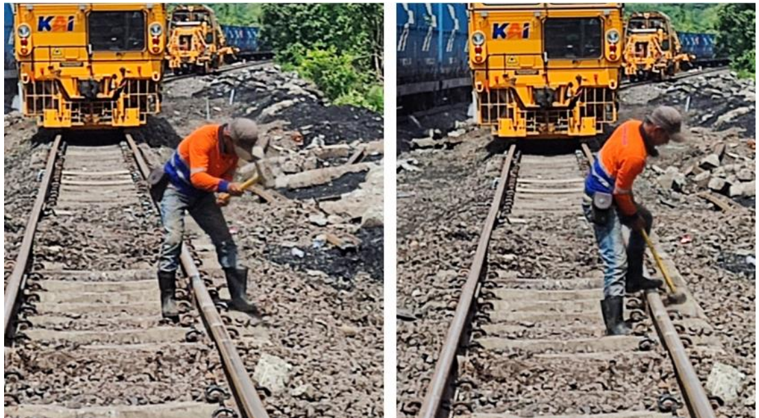
Gambar 29. Pemasangan penambat dengan palu
