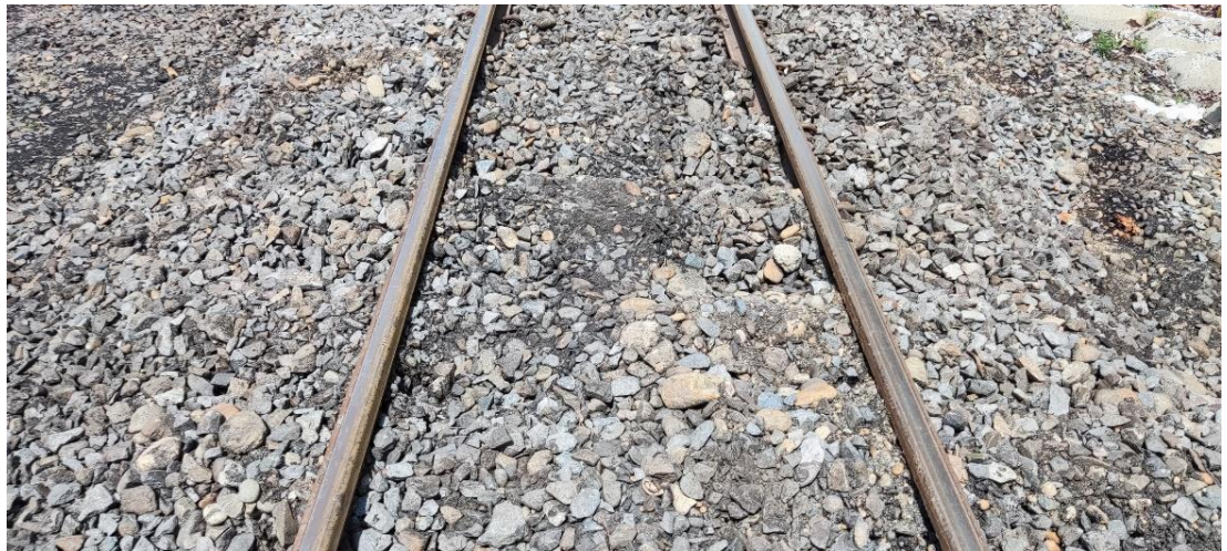
Gambar 28. Kondisi balas jalur hulu setelah pemecokan balas (09-11-2022)
