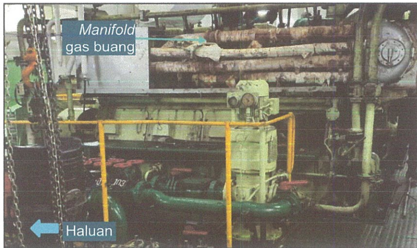
Gambar 6 Mesin Bantu No. 3 Saat Overhaul Penggantian Cyl. Liner No. 2 Tanggal 4 Juni 2024
